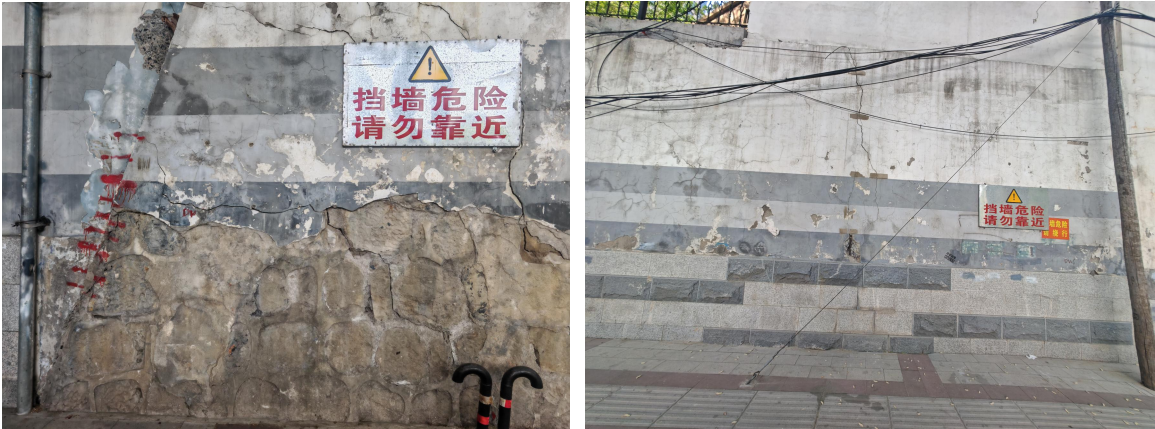
图 3.4 既有墙体现状
